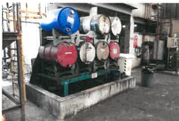
Foto 3: Deposito oli con bacino di contenimento
