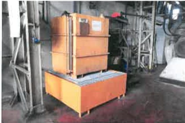
Foto 5: Deposito prodotti con bacino di contenimento
