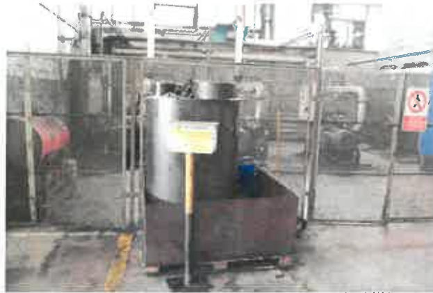
Foto 4: Deposito olio esausto con bacino di contenimento
