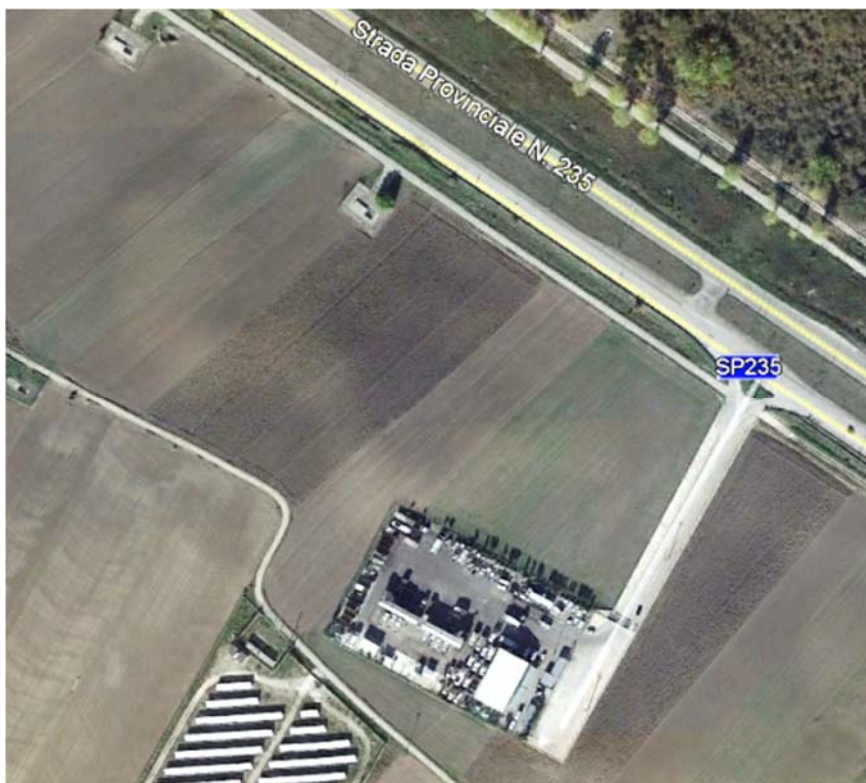
Fig. 5 – Impianto di Trasferenza e viabilità di accesso all'area dalla SP n. 235
