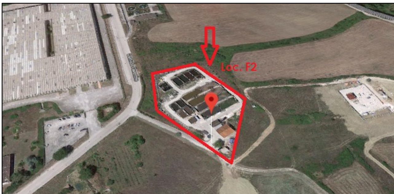
Figura 1 Area dov'è ubicato l'impianto (vista dall'alto)
