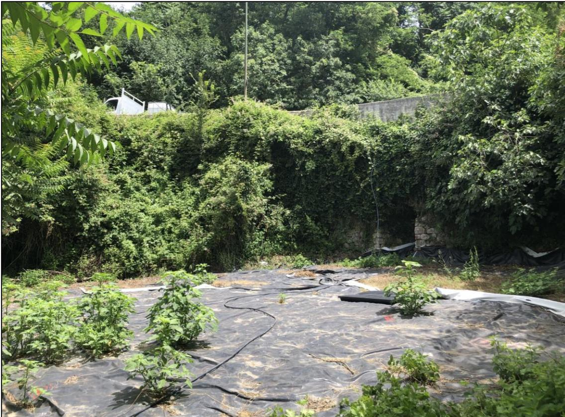
Successivamente lo scavo verrà ripristinato mediante riporto e compattazione di terreno agrario certificato di idonee caratteristiche fisico-meccaniche per la riconfigurazione morfologica dell'area, con posa di geotessuto a delimitazione del terreno in posto da quello di ripristino. Il terreno di ripristino verrà costipato mediante rullo compattatore e infine l'area verrà impermeabilizzata con telo in polietilene fino all'ottenimento dei risultati analitici di collaudo.
