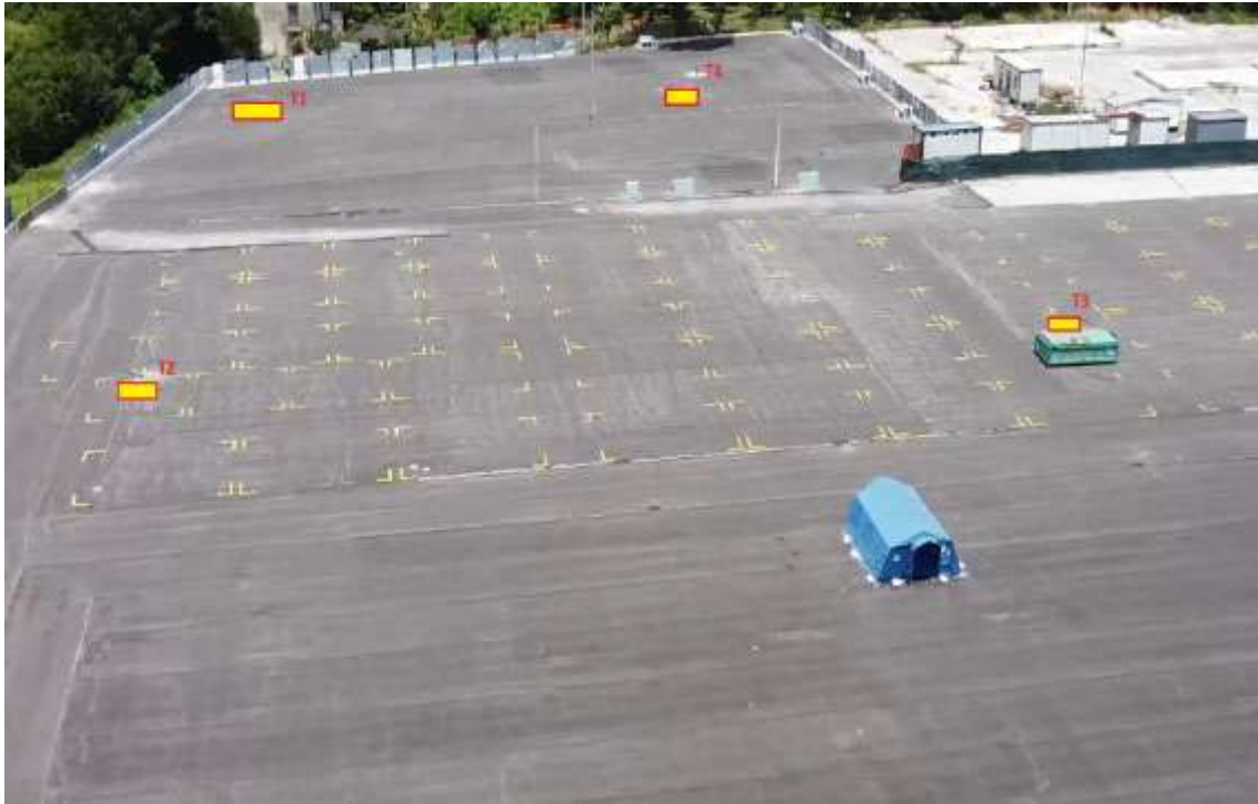
Fig. 3.3 - Ubicazione trincee geognostiche di giugno 2020
