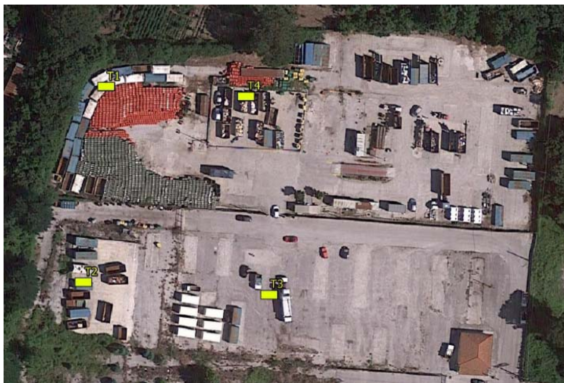
Fig. 6.2 - Ubicazione trincee geognostiche di giugno 2020
