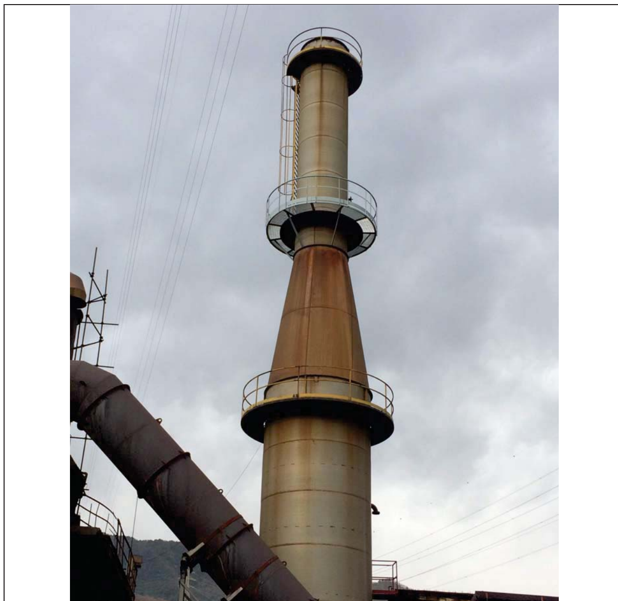
Figura 2.3 – Fonderie Pisano: stralcio fotografico della sorgente emissiva E1 – camino (Data: maggio 2016).
