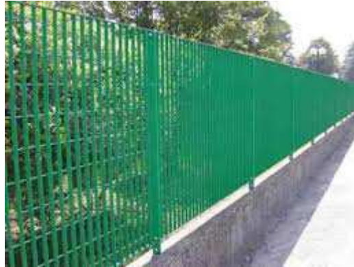
Foto 1 (esempio di recinzione metallica)
