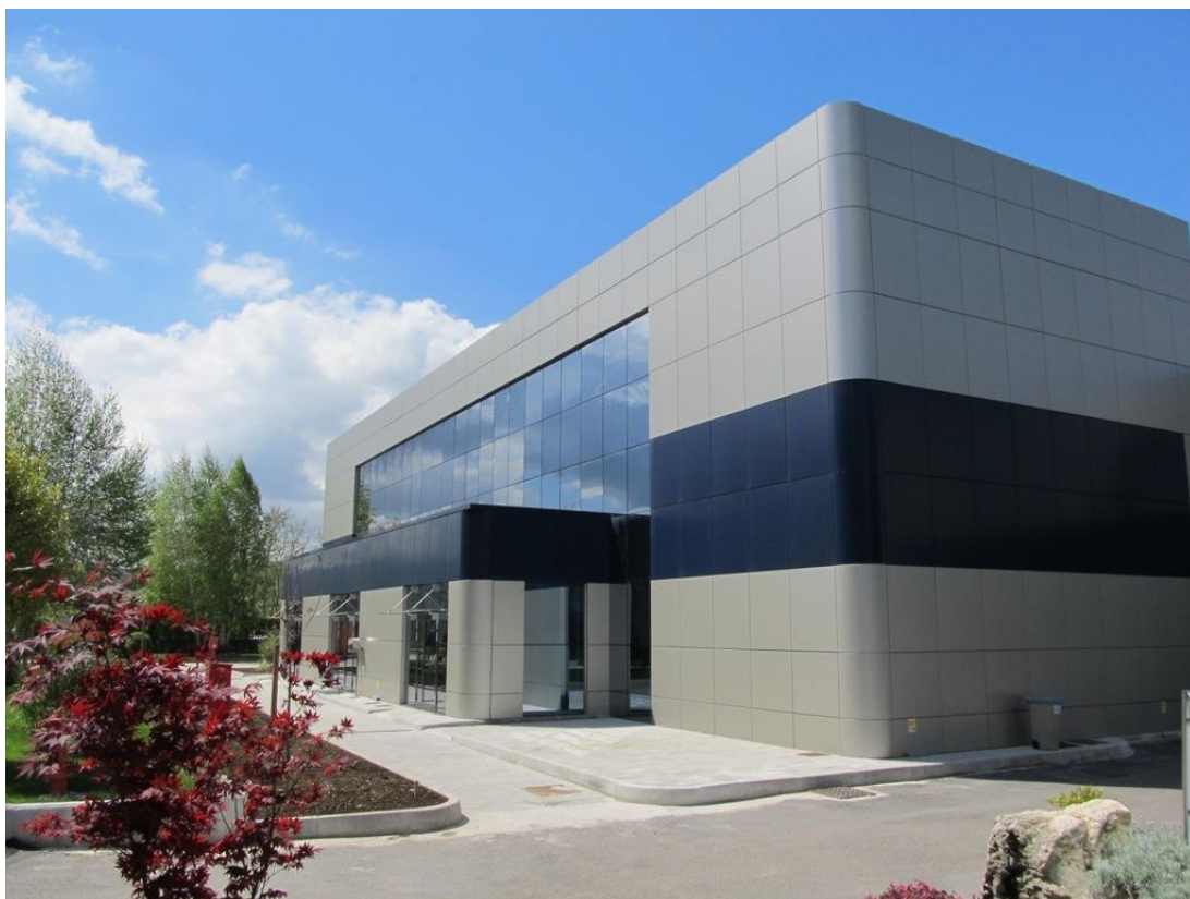
Figura 3 - Particolare edificio interno allo stabilimento Altergon
