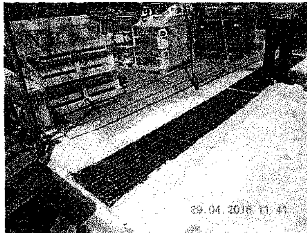
Foto n. 10 Griglia di raccolta all'ingresso dell'area stoccaggio coperta
