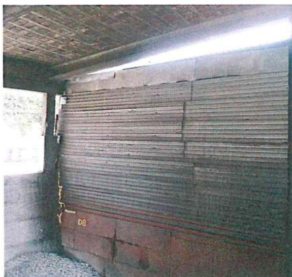
fig.1 - paratie in lamiera a parziale confinamento
