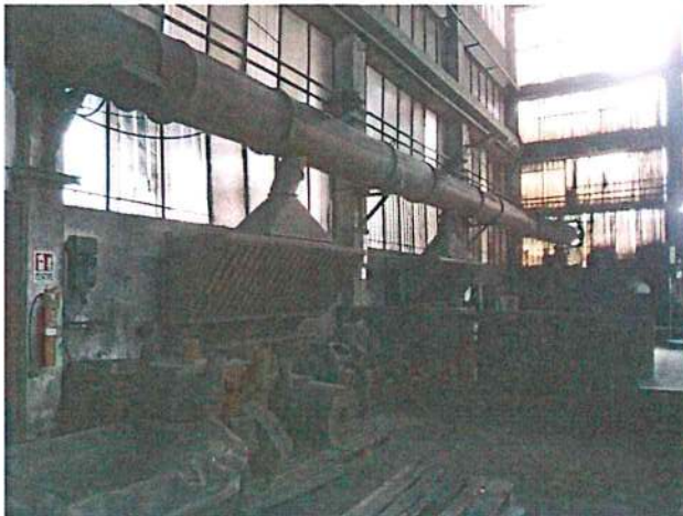
fig. 6 – cappe di aspirazione interne al capannone granigliatura
