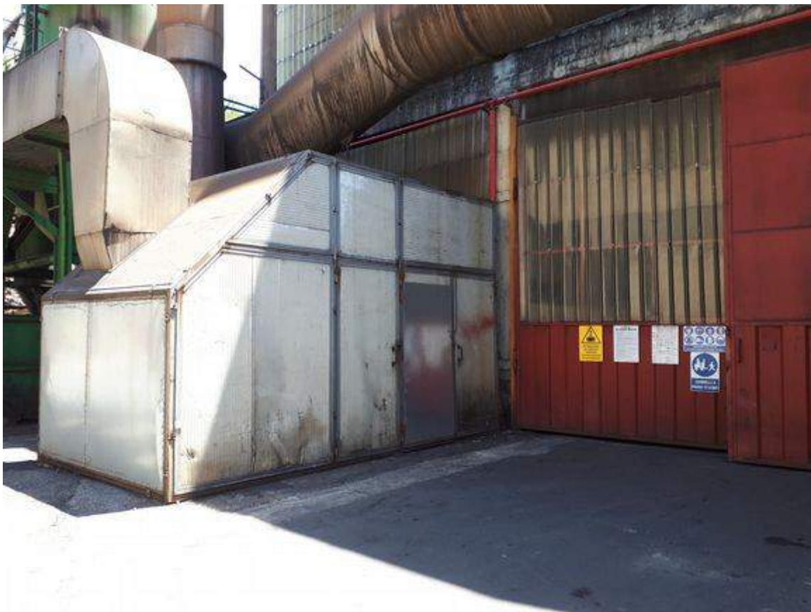
Fig.9 Sistema di insonorizzazione dei motori di ventilazione del filtro F3 (fase di disterratura)
