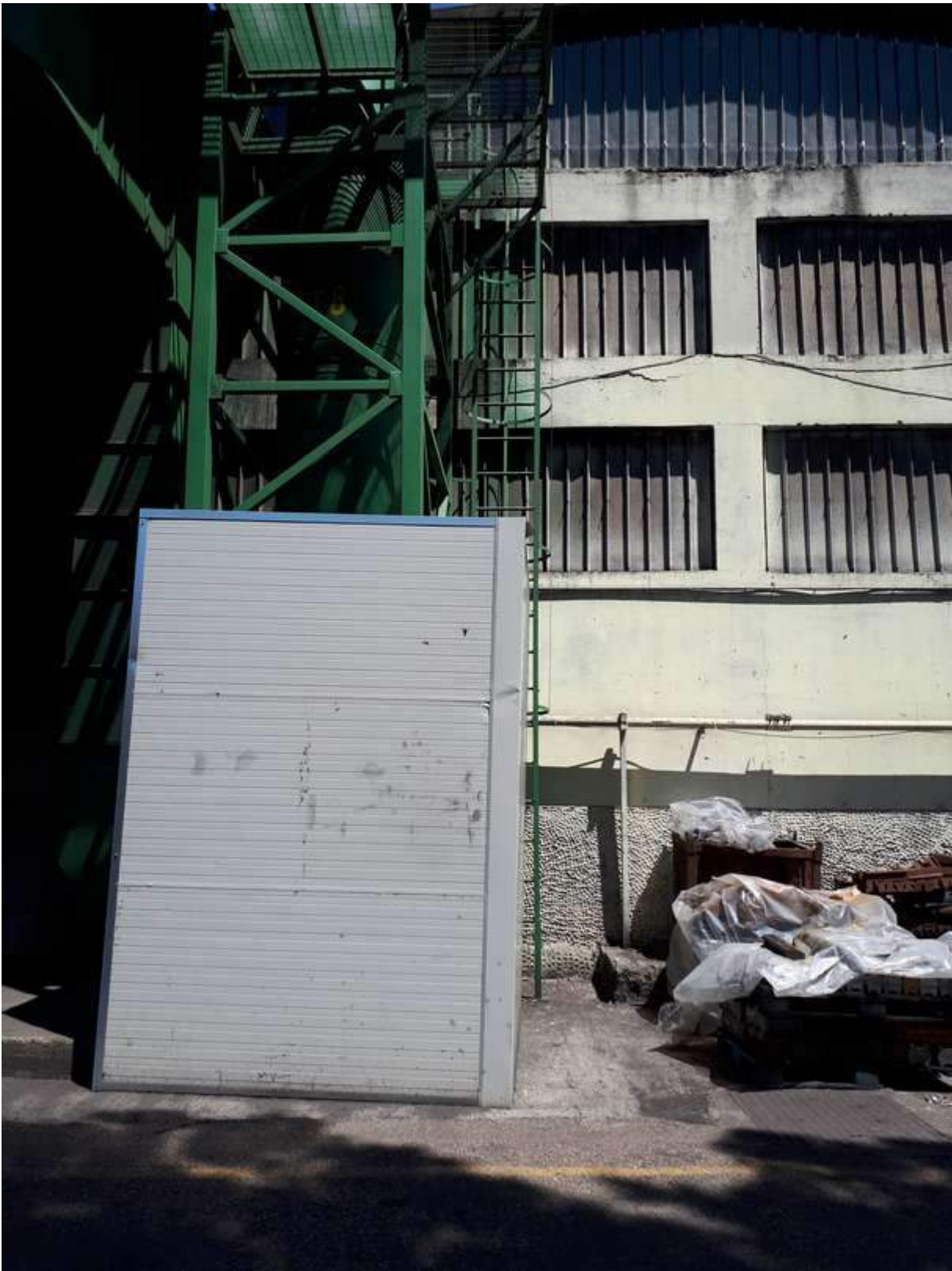
Fig. 4 Barriere fonoassorbenti per il camino E8 (sbavatura ceppi freno)
