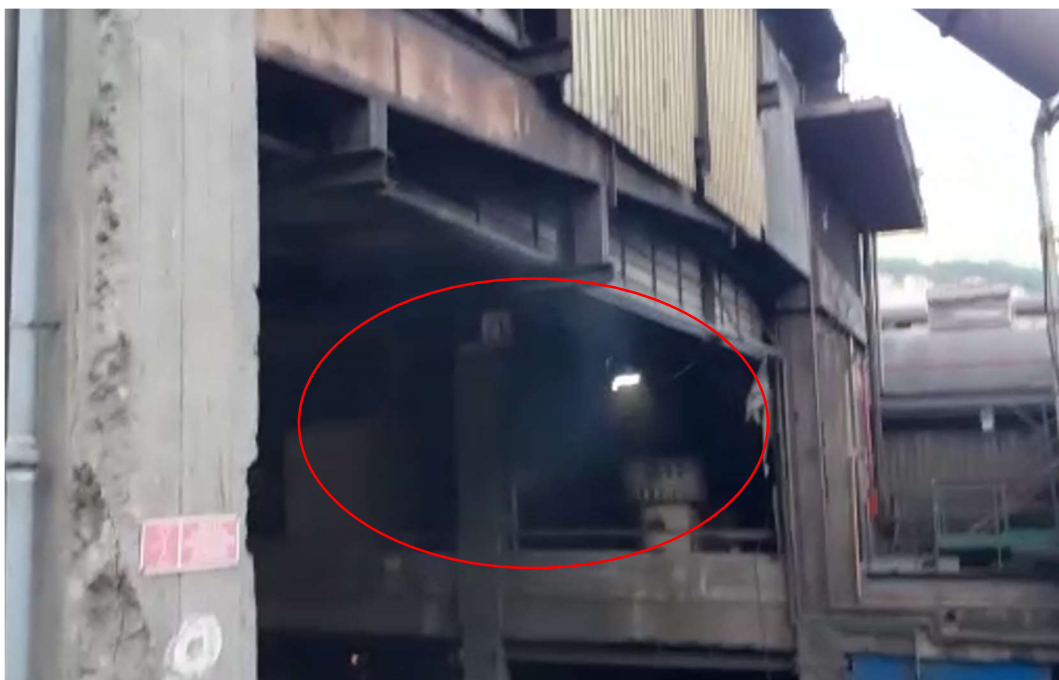
Fig.2 – in questa foto sono chiaramente visibili le emissioni di fumo nell'area esterna al "cubilotto" (area cerchiata in rosso)
