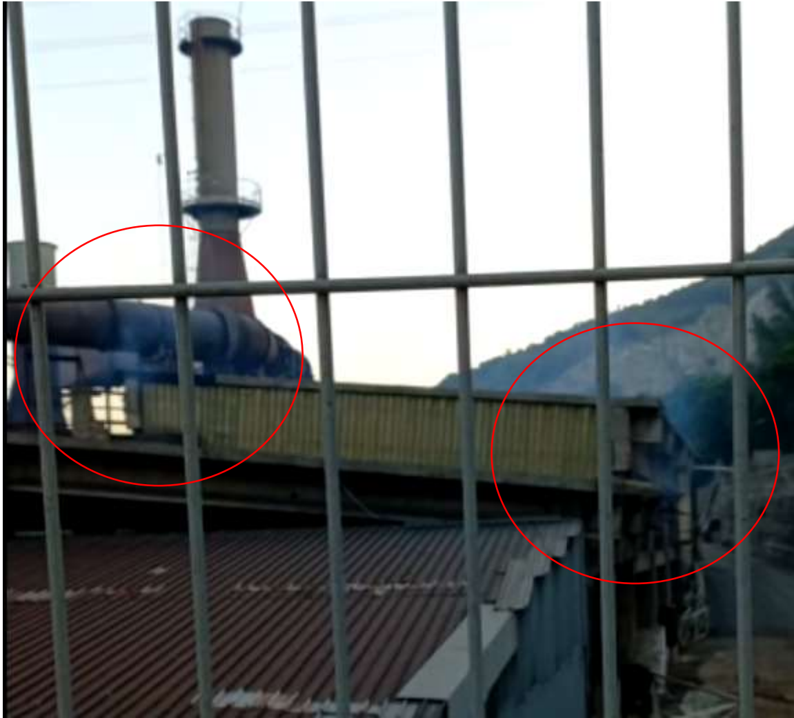
Fig.1 – foto scattata dalla piazzola autostradale- in questa foto sono chiaramente visibili le emissioni di fumo (area cerchiata in rosso)
