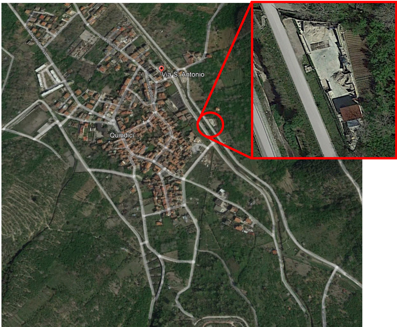
Fig.1: Veduta aerea zona in esame con ubicazione dell'area- fonte Google Earth -
