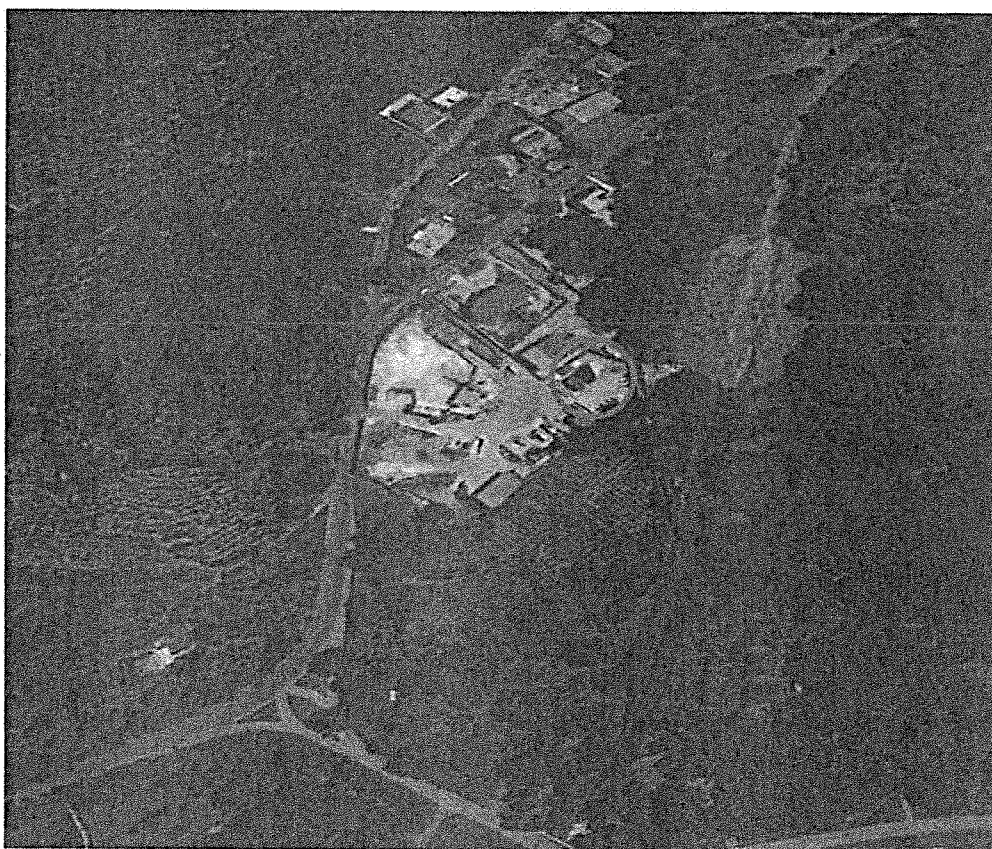
Fig.1: Veduta aerea zona in esame con ubicazione dell'area- fonte Google Earth -
